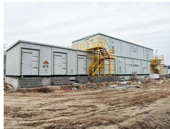
2022年12月 濮阳盛源能源科技股份有限公司 110kV变电站新建工程PC总承包项目
