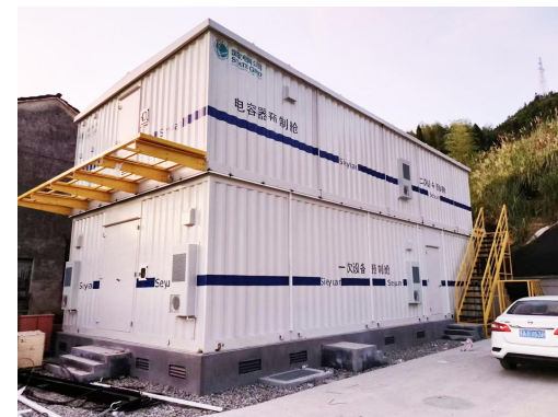
2022年6月 淳安中州临时变项目
