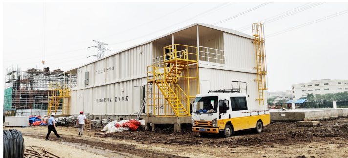
2022年9月 江苏正力110kV变电站工程
