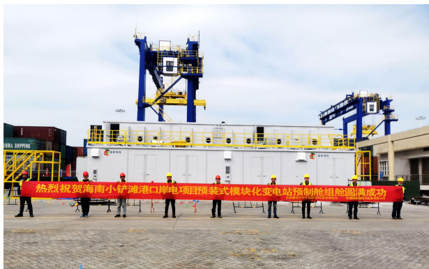
2020年12月 海南港口岸电工程 小铲滩港口岸电系统项目
