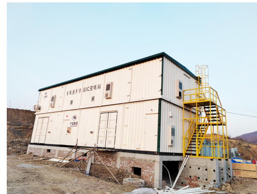
2022年12月 南召东升新能源有限公司马市坪 一期40MW风电场项目
